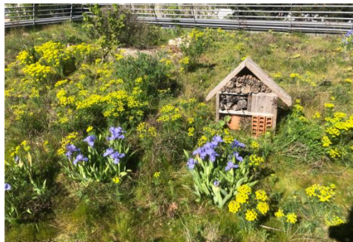
Une toiture de biodiversité à Nanterre Topager.com
