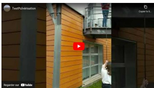
Essai de pulvérisation sur le mur
